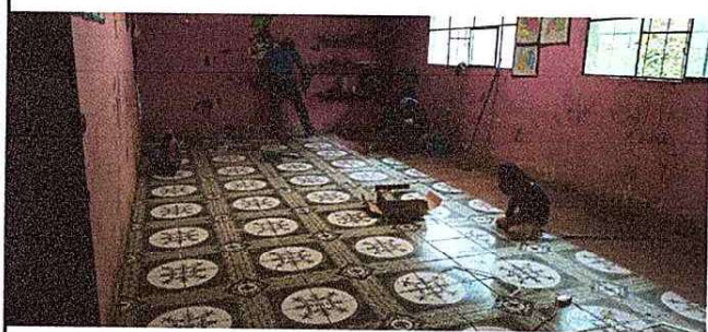
Foto 3: Colocando el piso
