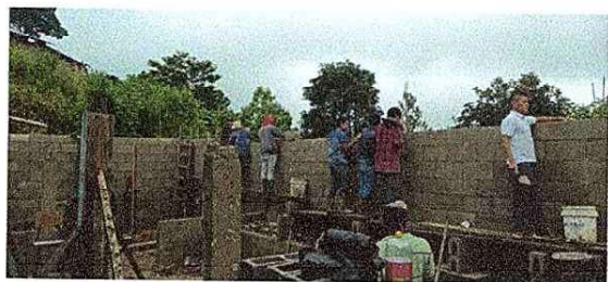
Foto 5: Rehabilitación de block de un modulo.
