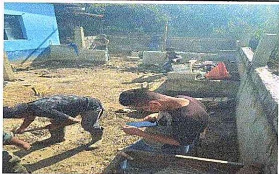
Foto1: Empezando la colocacion de block para terminar las paredes.
