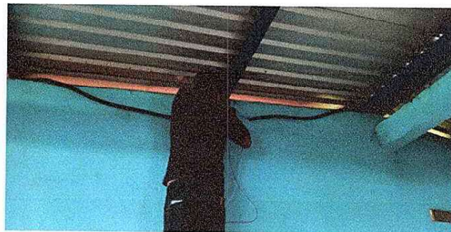
Foto 2: Colocando el sistema electrico
